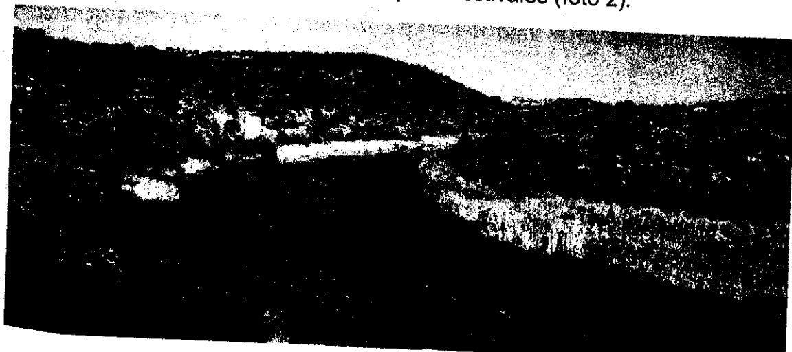
Foto. 2. Embalse de Aulencia. Estado de colmatación del vaso –febrero 2004-.
